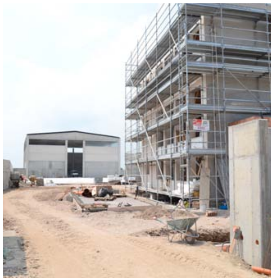
Il cantiere in evoluzione
